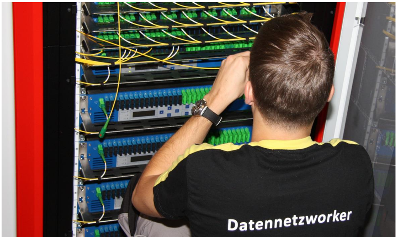
Schritt für Schritt zum schnelleren Netz. Höchste Installationsqualität, zielorientierte und planmässige Durchführung
