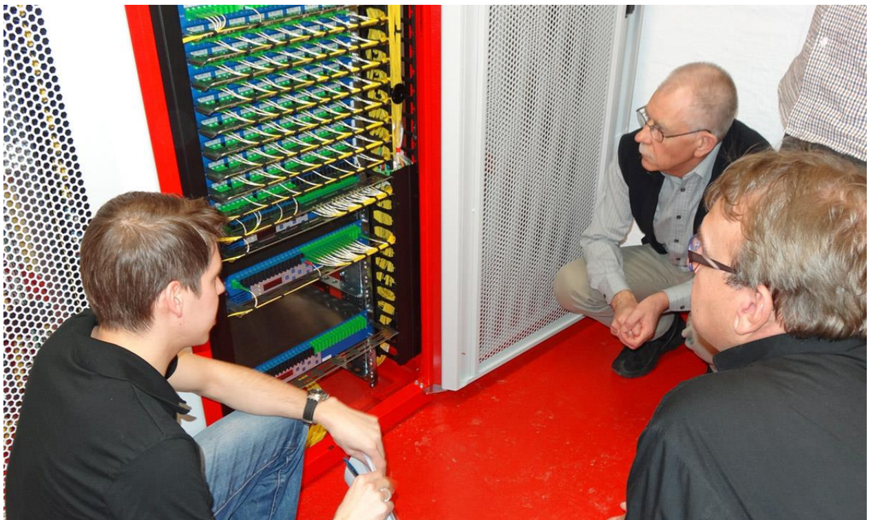
Mehr Leistung und Sicherheit für Kabelnetzunternehmungen. (Systemabnahme durch die Bauherrschaft)
