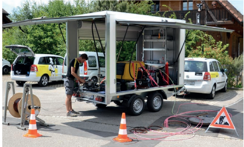
Mobile Glasfasereinblastechnik – Einsatzbereit in fünf Minuten
