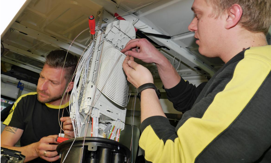
Abbildung: Spleissen der Glasfaserkabel
