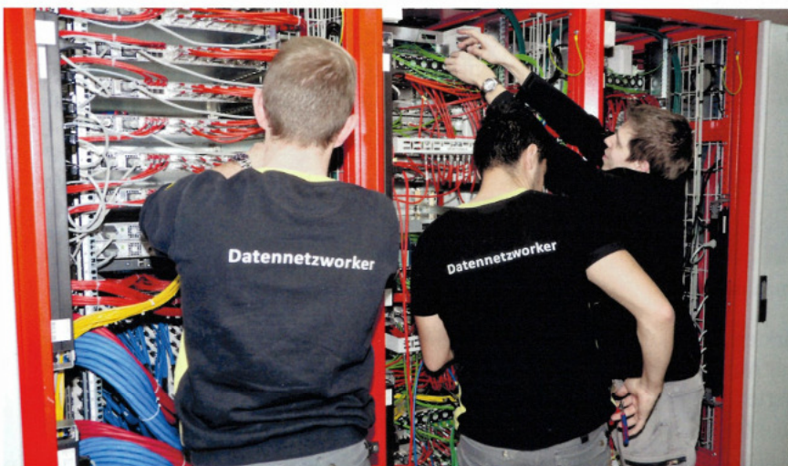
Infra-Com Swiss-Mitarbeiter bei den nächtlichen Migrationsarbeiten
