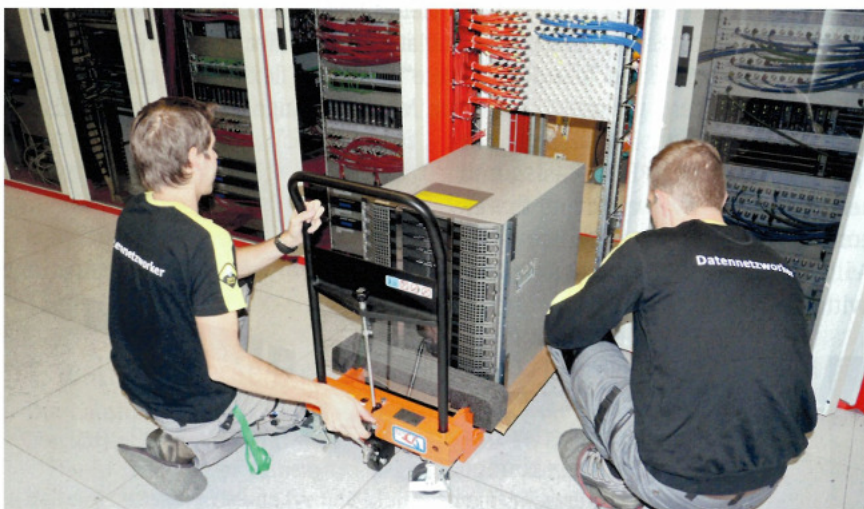
Transport der neuen CMTS
