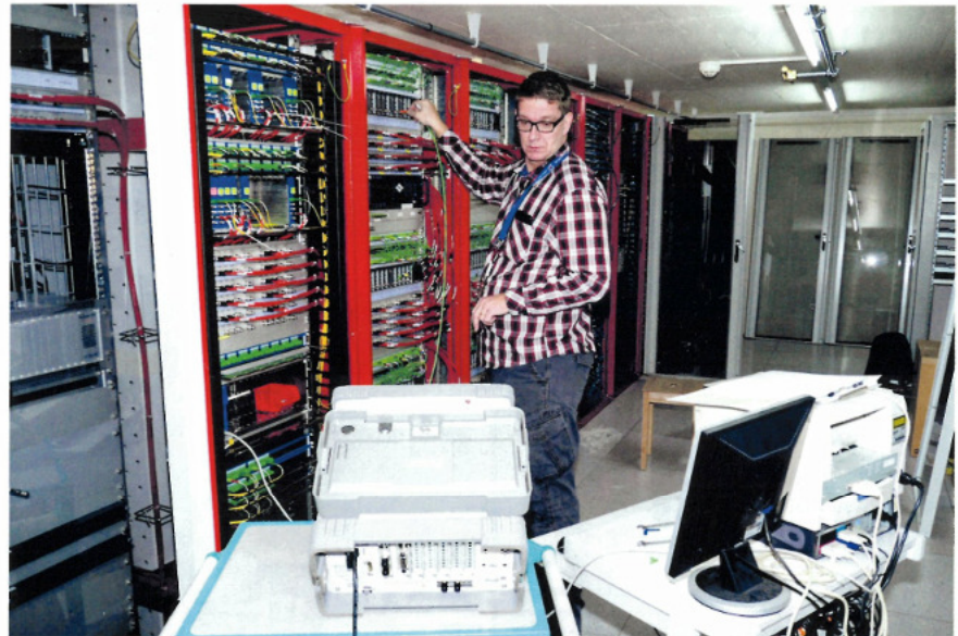
Helmuth Both, Signum Engineering, beim Einpegeln der Laser
