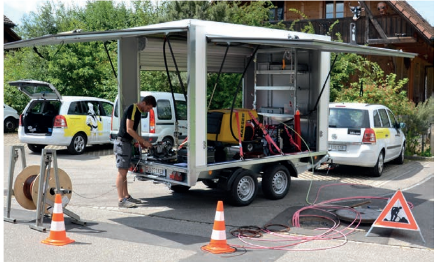
Mobile Glasfasereinblastechnik – Einsatzbereit in fünf Minuten
